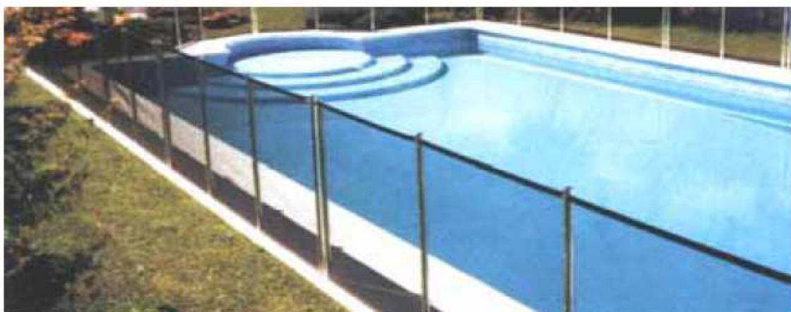
Bild 9. Nätet måste vara väl spänt mellan de separata stolparna
