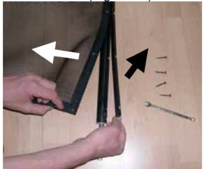
Bild 11. Lossning av de 10 skruvarna på fästlisten till nätet och friläggning av nätet
