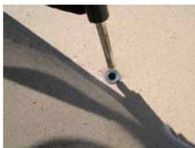
Bild 5. Fästning av golvförankringsbeslag
